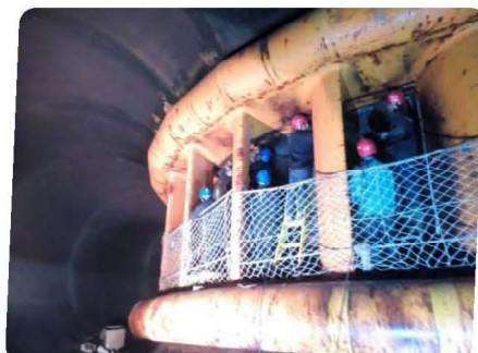
向家坝安装现场(5F~8F)
