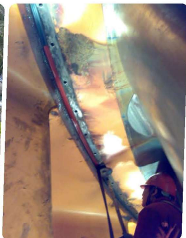
三峡安装现场
